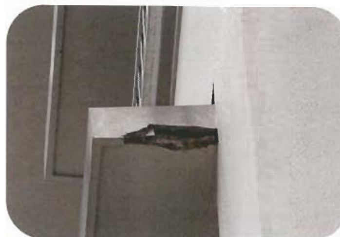
危険部撤去後
