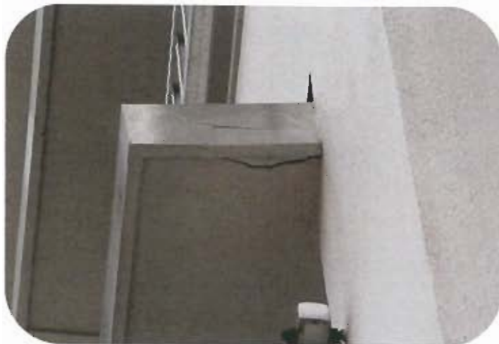
危険部撤去前
