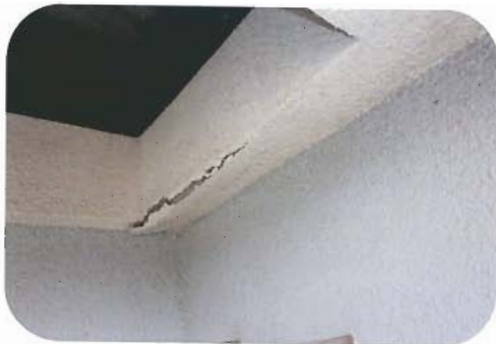
危険部撤去前
