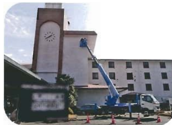
目視・打診調査(高所作業車使用)
