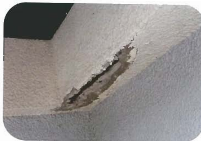
危険部撤去後
